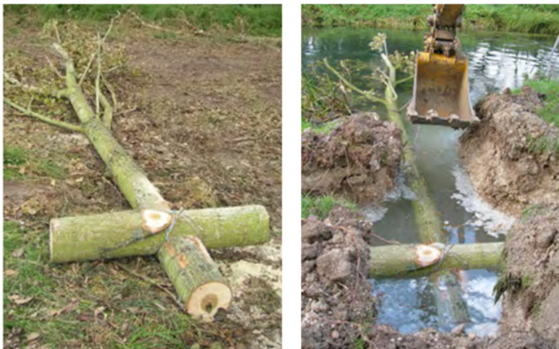
Figur 45: Trær må festes på en tilstrekkelig måte i elvekanten for å ikke bli revet løs av vannstrømning. En mulig løsning er vist på bildene og er beskrevet på nettsiden til The River Restauration Center https://www.therrc.co.uk/MOT/Final_Versions_%28Secure%29/
