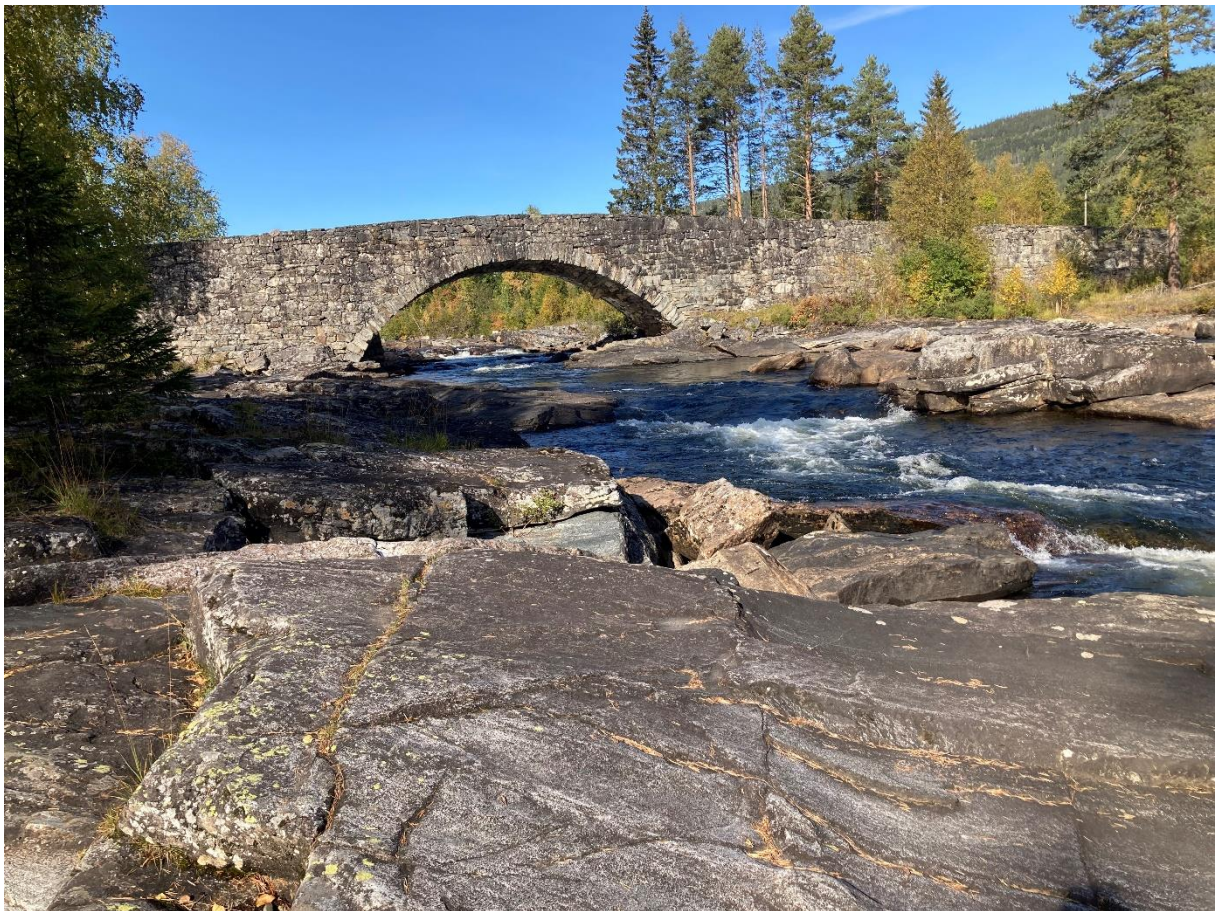
Lundebrua er gedigen og et unikt kulturminne.
