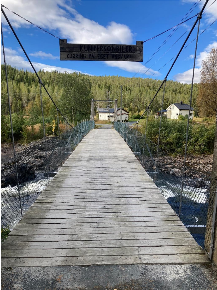
Brua med skilt om at man kjører på eget ansvar.
