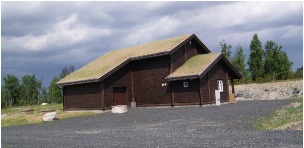
Lenningen SBR-rensanlegg med mørkbeiset ytterkledning og torvtak.
