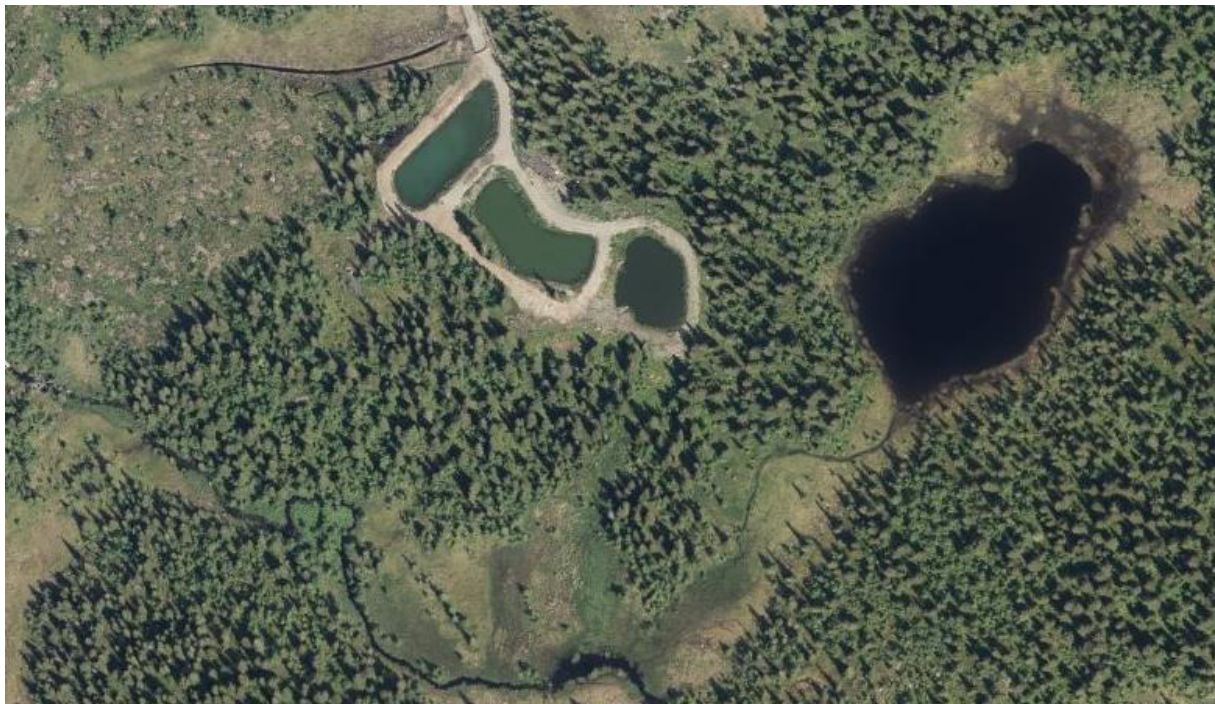
Flyfoto som viser de 3 biodammene og resipient Langtjednbekken i sør. Tobrenntjernet ligger rett øst for biodam-anlegget.
