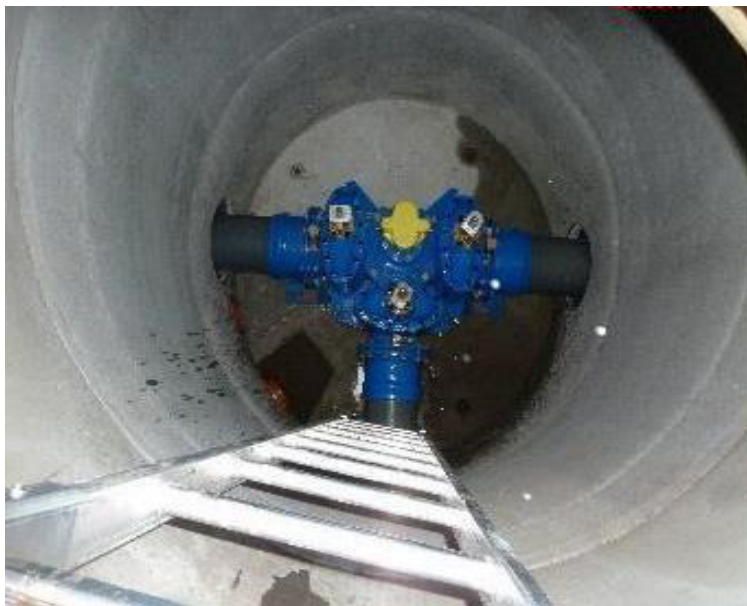
Eksempel på vannkum med ventilkryss og brannventil.
