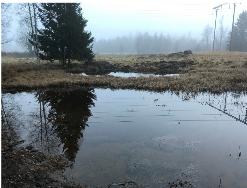
Figur 6 Åpent vannspeil er skap igjen gjennom å ta ut masser fra tjernet. Bildet er tatt under gjennomføring av tiltaket (L-Hoch 2022)
