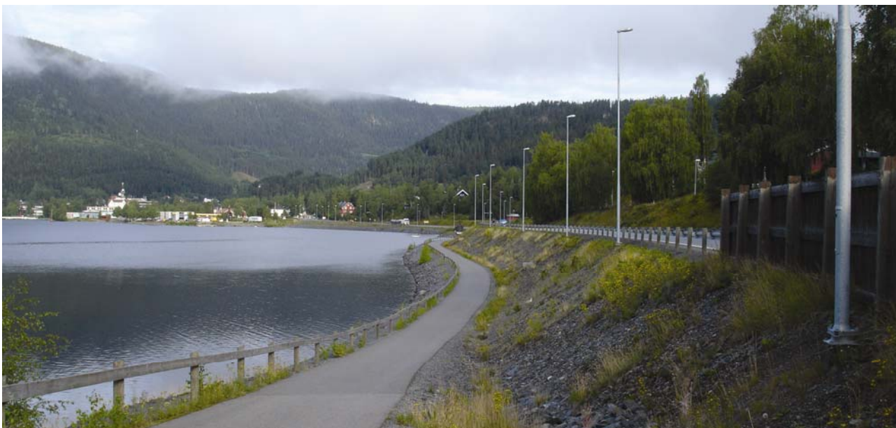
E16 med gangveg. Her har behovet for gangveg utvikla seg etter at området er utbygd, slik at einaste «ledige» sone for gangvegen var strandlina nedanfor vegen.
