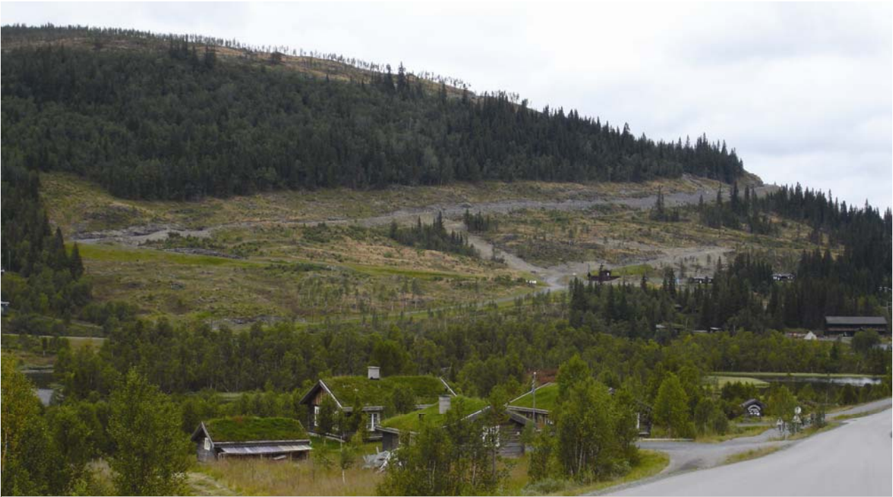
Veganlegg på Vaset. Store skjeringar saman med flatehogst har endra området sin karakter. Inngrepet står i klar kontrast til dei godt tilpassa bygningane i framkant.
