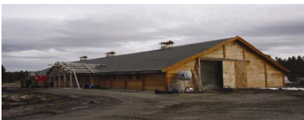
Døme på nytt fellesfjøs i Rendalen. Moderne konstruksjon med stålrammer er kombinert med massivt tømmer i tak og vegger. Eit solid bygg med gode proporsjonar som i stor grad er bygd av lokale materialar. Foto: Morten Holt.
