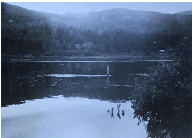
Figur 4.9: Foto av vannstandsmåleren ovenfor Eidshaugfossen under flom 20. august 1951. Vannstanden øket en del etter at bildet er tatt, så det bare var igjen 20-25 cm før det ville gått over vannmerket. (NVE-arkiv Hamar, nr. A4977, mappe III).
