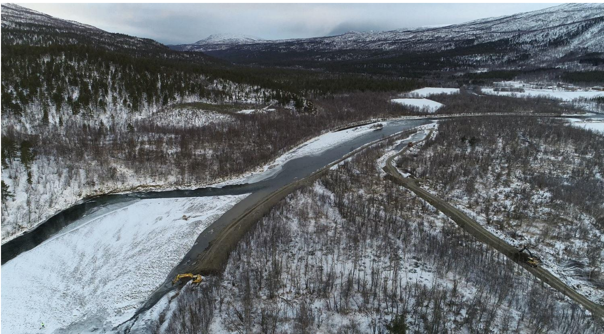
Figur 5.4: Flytting av flomvoller i Skaktarelva/Divieelva, anleggsarbeidene. Datakilde: Sturla Dimmen Sæle (NVE)
