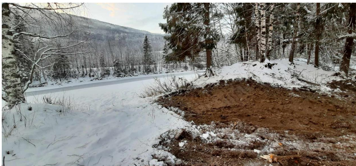
Figur 4 Senkning av flomvoll mot Etna (foto: G. Høitomt 2022)
