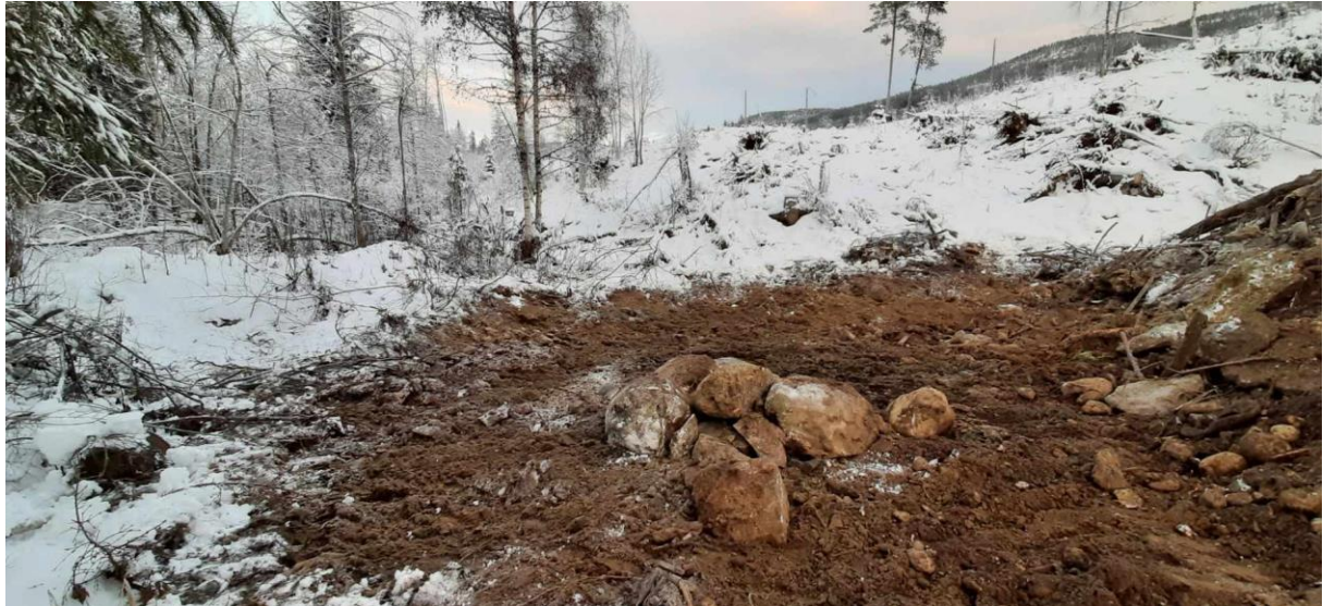
Figur 5 Større steiner ble lagt til sida under arbeidet for å kunne brukes som steinutlegg i Etna til et senere tidspunkt. (foto: G. Høitomt)
