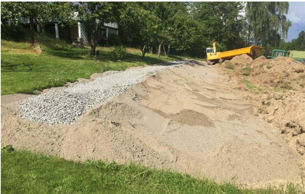
Figur 2: Bilde av oppbygd infiltrasjonsfilter med tilkjørt sand og pukk, delvis etablerte sandrygger og drenerende sandmasser lagt ut nedstrøms infiltrasjonsflaten
