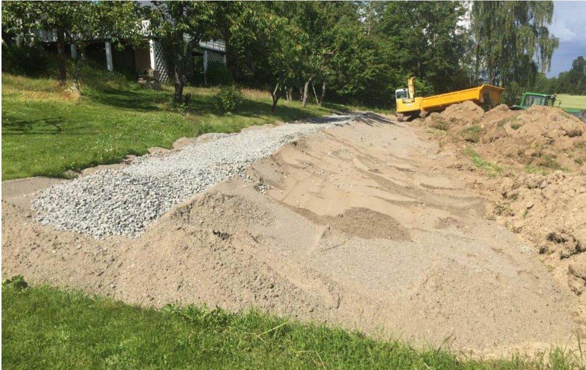
Figur 1: Bilde av oppbygd infiltrasjonsfilter med tilkjørt sand og pukk, delvis etablerte sandrygger og drenerende sandmasser lagt ut nedstrøms infiltrasjonsflaten
