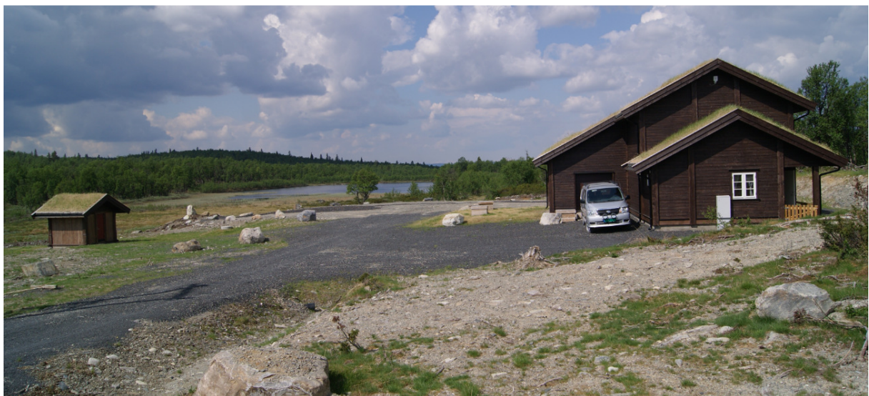
Lenningen renseanlegg med avløppspumpestasjon til venstre på bildet og «Settefiskdammen» i bakgrunnen.
