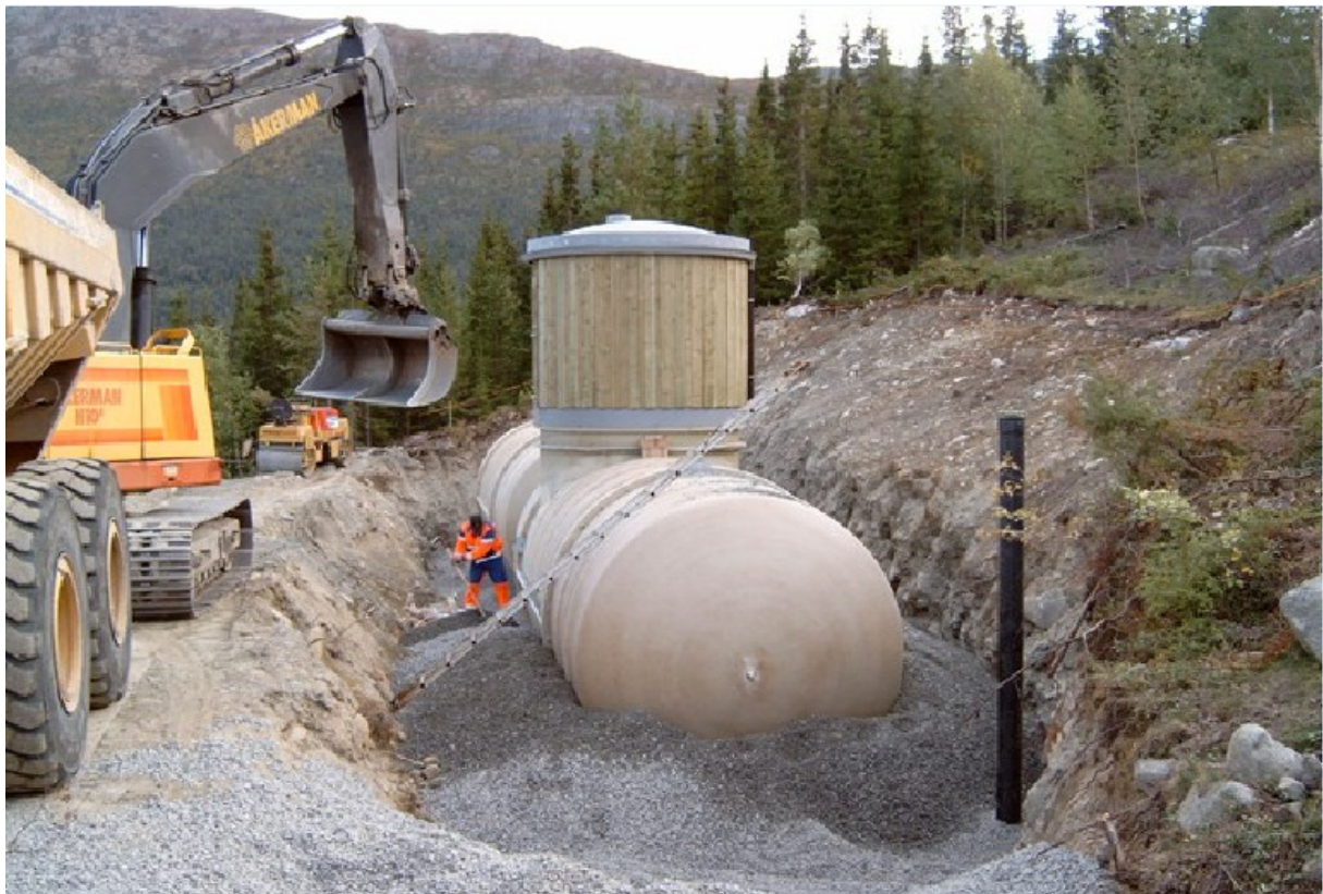
Her ser vi et eksempel på nedgrav GUP høydebasseng med kontrollrom.
