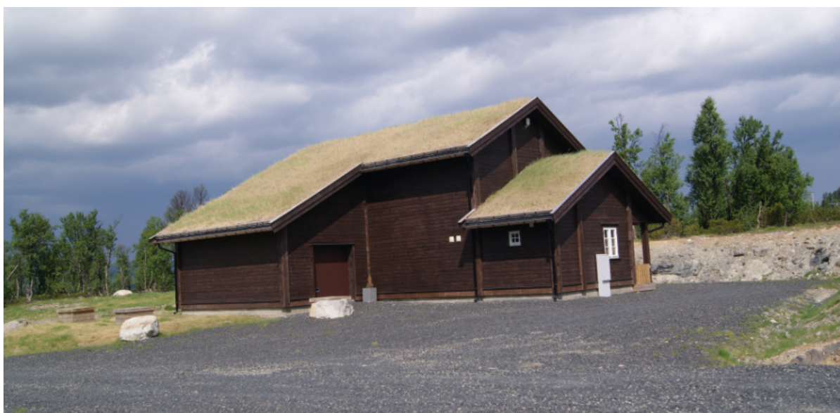
Lenningen renseanlegg med mørkbeiset ytterkledning og torvtak.
